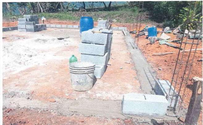
Foto 3: colocacion de la base
