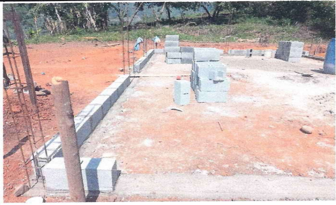
Foto 1: colocacion de block
